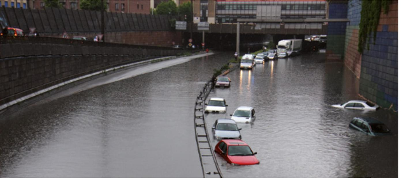
Les pouvoirs publics sont de plus en plus attentifs à la prévention des risques d'inondation et au fait de devoir trouver des solutions pour infiltrer l'eau de pluie de manière décentralisée. L'augmentation constante des surfaces de ruissellement imperméabilisées (habitations, parkings, zones commerciales, routes), entraîne une saturation progressive des réseaux d'évacuation et accroît d'autant les risques d'inondation.
